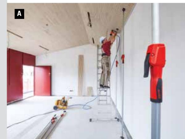
**A Support télescopique STE pour cloisons sèches avec poignée à pompe**
